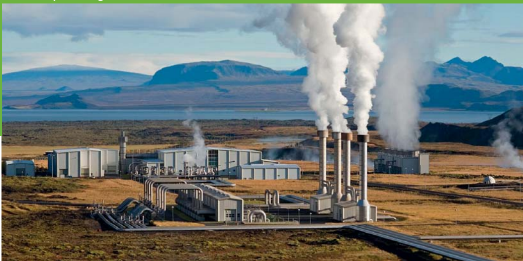
Elektrociepłownia geotermalna na Islandii
