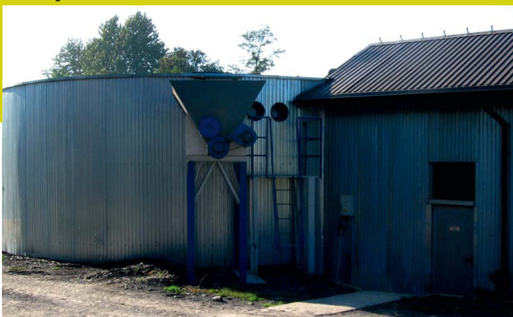
Mikrobiogazownia rolnicza w Studzionce
